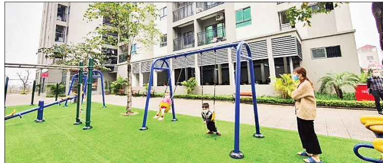
Công tác bảo trì có tác động lớn đến tuổi thọ, chất lượng công trình xây dựng.
