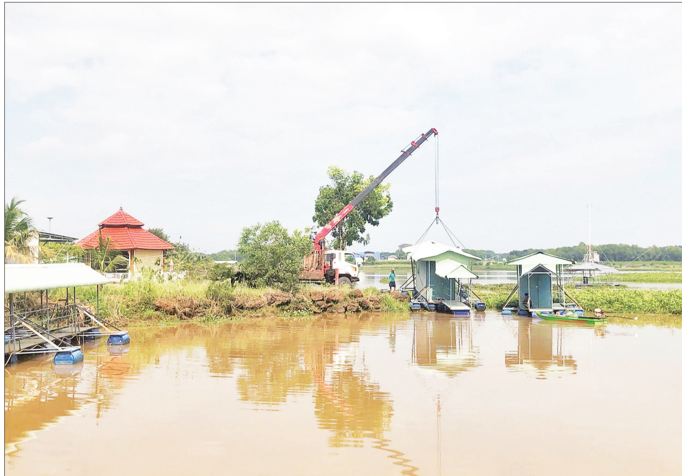
Người dân tỉnh Bình Phước tự tháo dỡ công trình vi phạm năm 2024. (Ảnh TẠ ĐÌNH TIẾN)
