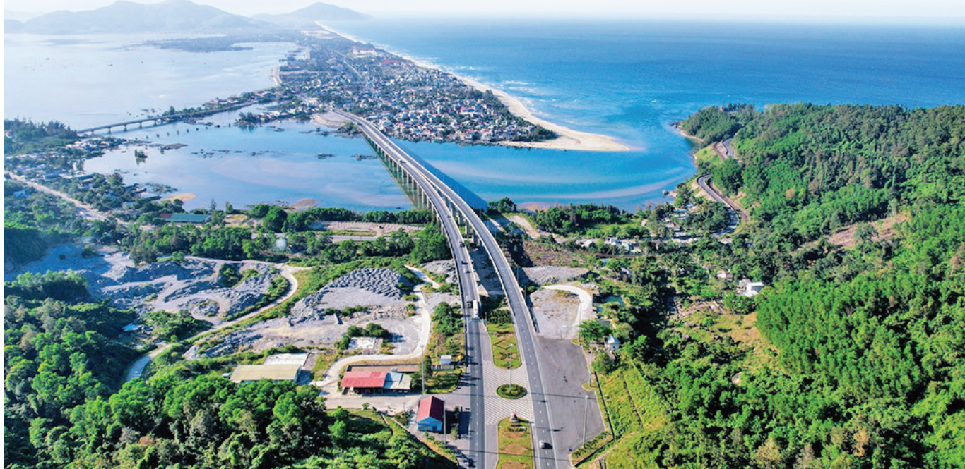
Hạng mục dự án mở rộng hầm đường bộ Hải Vân của Tập đoàn Đèo Cả.
