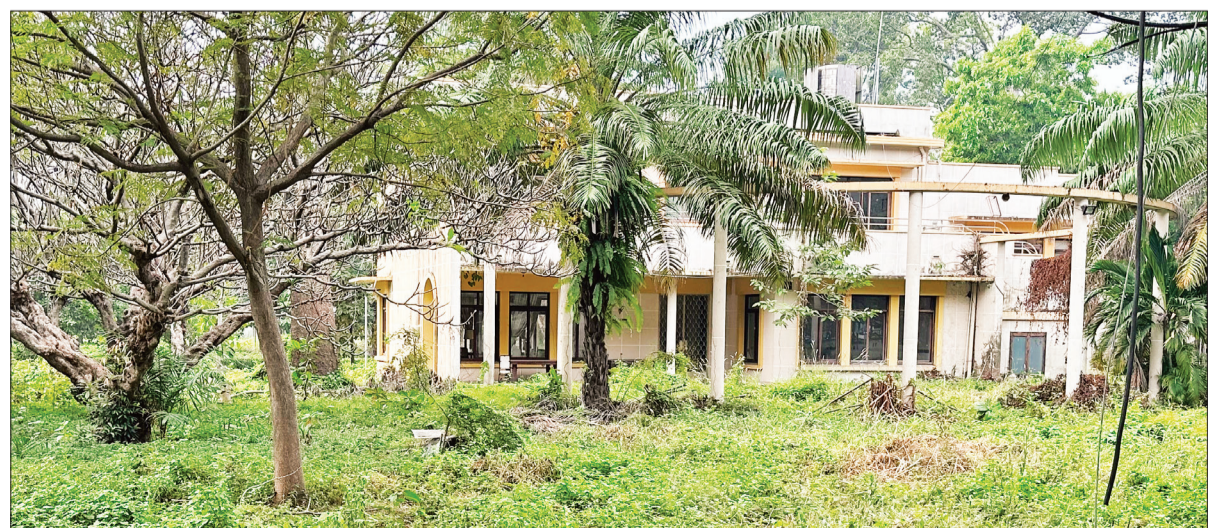
Khu nhà khách Chính phủ ở số 1 Lý Thái Tổ, Quận 10 gần như bị bỏ trống từ nhiều năm qua.
