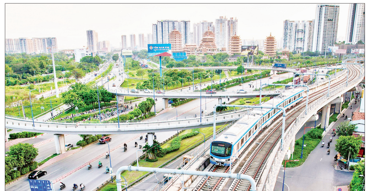
Thành phố Hồ Chí Minh vừa đưa vào khai thác tuyến metro số 1 (Bến Thành-Suối Tiên) sau nhiều năm thi công.
