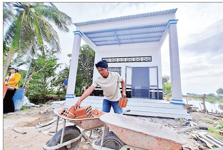
Căn nhà sắp hoàn thành tại xã Trĩ Phải, huyện Thới Bình, nằm trong Chương trình xóa nhà tạm, nhà đột nát trên địa bàn tỉnh Cà Mau.
