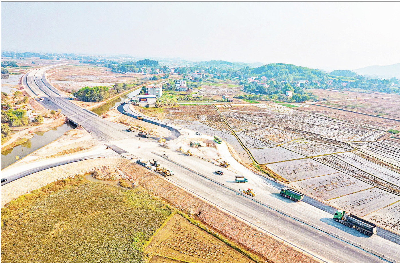
Đường liên kết Thái Nguyên-Bắc Giang-Vinh Phúc cơ bản hoàn thành, sẽ đưa vào sử dụng từ quý II/2025, sớm hơn sáu tháng so với tiến độ đề ra.
