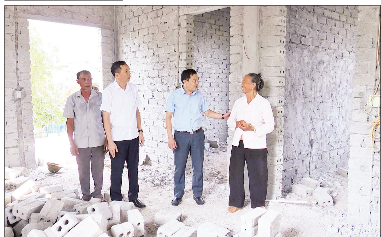
Lãnh đạo xã Thanh Lâm kiểm tra tiến độ xây dựng nhà tạm gia đình bà Trần Thị Trâm, thôn Trung Hiếu Thượng.
