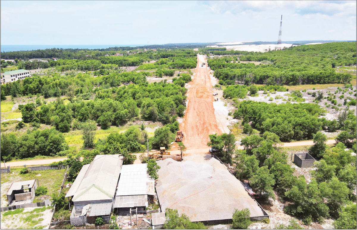
Dự án đường ven biển tỉnh Quảng Trị (cà) vương mức mặt bằng nên gặp nhiều khó khăn khi thi công các gói thầu.
