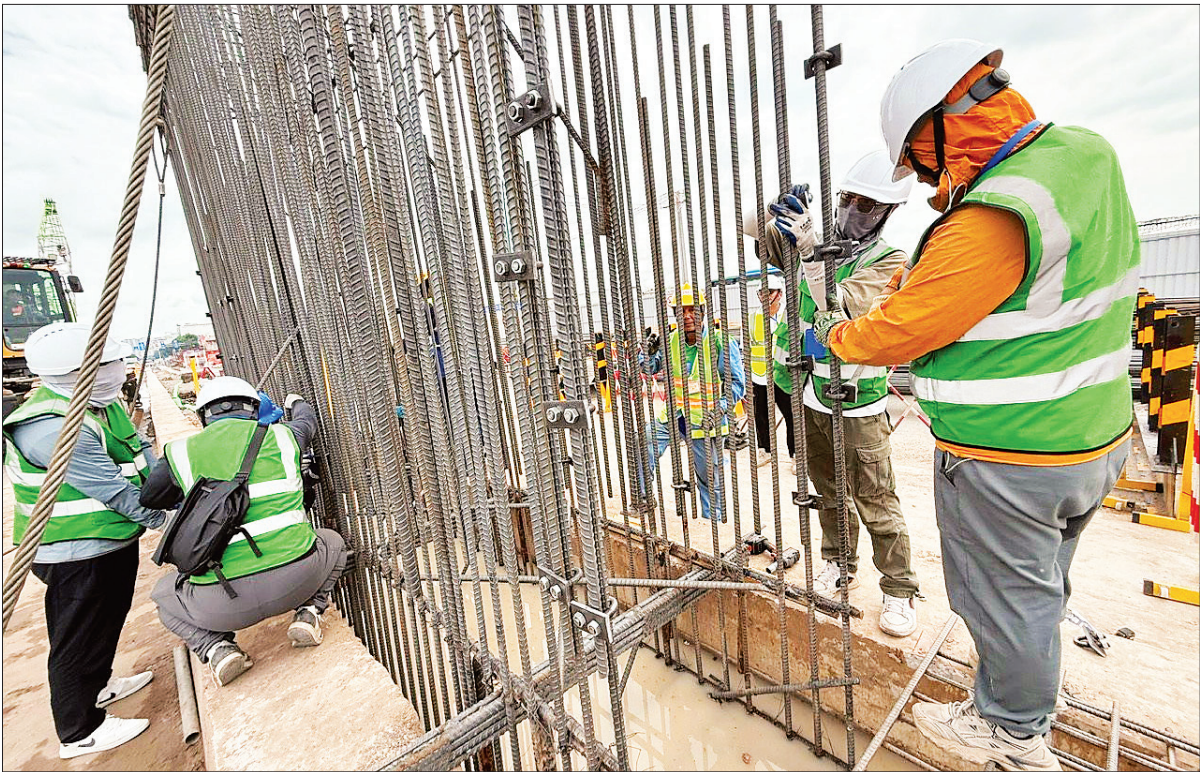
Thi công khu vực nhà ga Phạm Văn Bạch thuộc tuyến metro số 2 (đoạn Bến Thành-Tham Lương).
