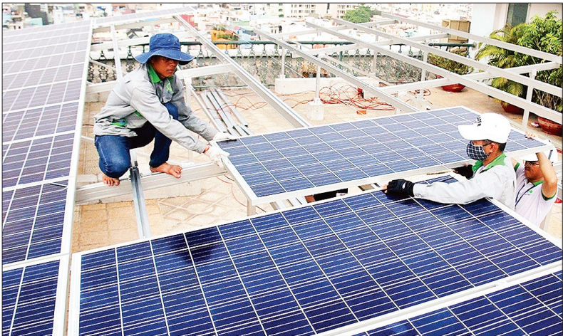
Công nhân lắp đặt điện mặt trời tại Thành phố Hồ Chí Minh.
