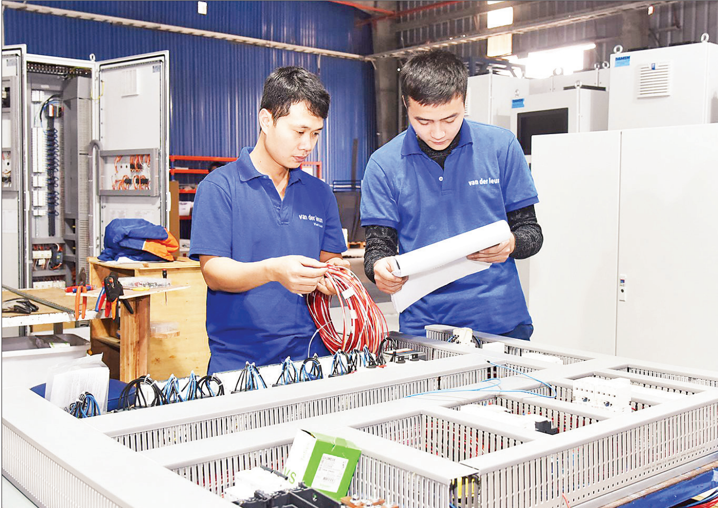
Công nhân Công ty TNHH Van Der Leun Việt Nam (Hải Phòng) kiểm tra, lắp ráp tủ bảng điện cho tàu thủy. (Ảnh KHANH AN)
