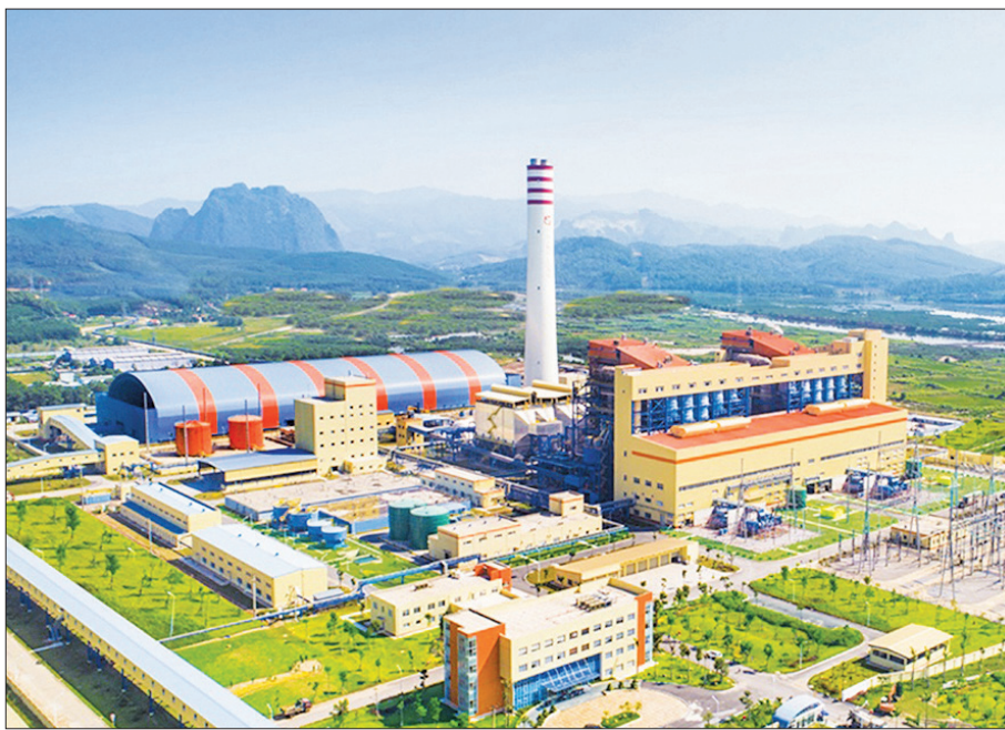
Nhà máy Nhiệt điện Thăng Long.
