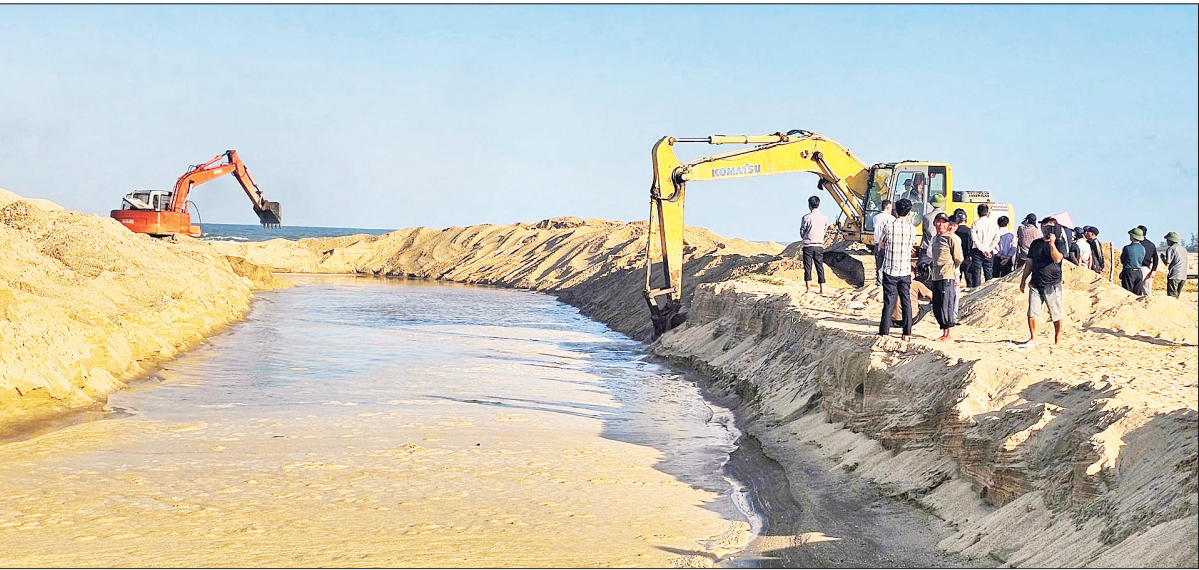
Xã Đông Trạch, tỉnh Quảng Trị huy động nhân lực, phương tiện đào cát lấp cửa sông Dinh lấy đường thủy cho ngư dân ra biển.
