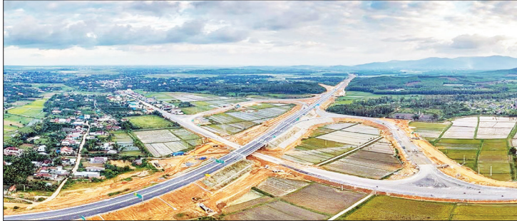
Dự án đường cao tốc Quảng Ngãi-Hoài Nhơn chiều dài 88 km, đi qua địa bàn 2 tỉnh Quảng Ngãi và Gia Lai (Ảnh HC)
