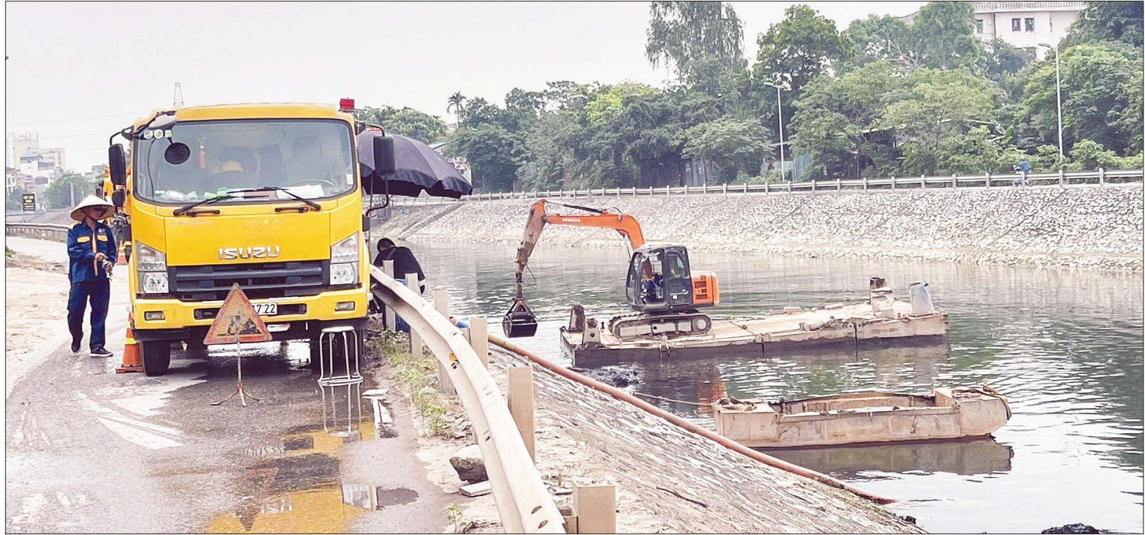
Công nhân Công ty TNHH MTV Thoát nước Hà Nội nạo vét lòng sông Tô Lịch, chuẩn bị cho mùa mưa 2026.
