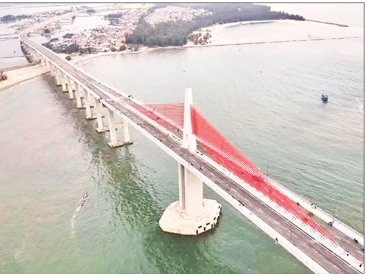
Cầu vượt cửa biển Thuận An, thành phố Huế vừa chính thức thông xe (Ảnh DUƠNG QUANG TIẾN)
