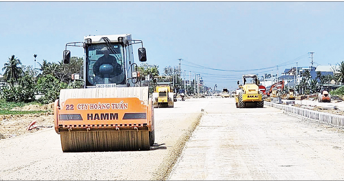
Phương tiện cơ giới thi công hoàn thiện đường giao thông Ngã ba Voi - Sầm Sơn, tỉnh Thanh Hóa.
